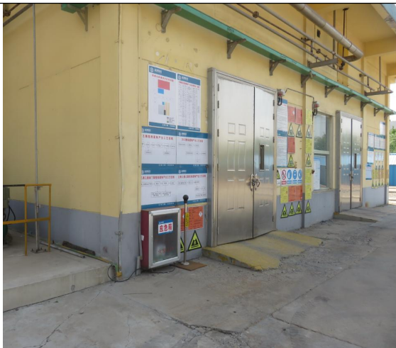
危险废物暂存间
