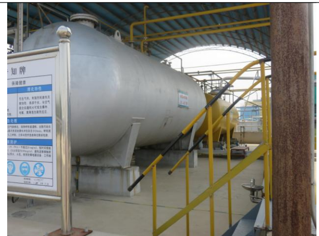
罐区围堰及围堰内防渗（液氨罐区）
