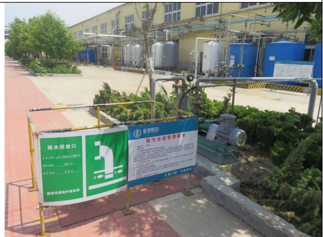
厂区雨水排放口
