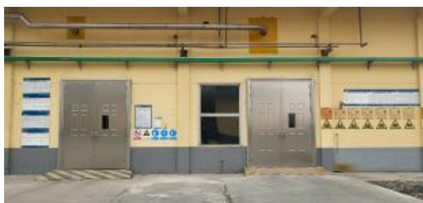
危废暂存仓库
